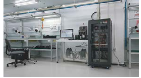
Hệ thống tự động kiểm tra Bộ điều khiển động cơ điện.
